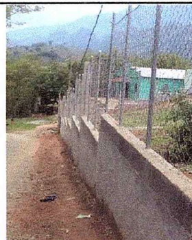
Foto 2: El muro perimetral enfrente de la escuela despues de haberse terminado.
