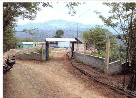
Foto 4: parte de adelante del muro perimetral de esta forma a quedado
