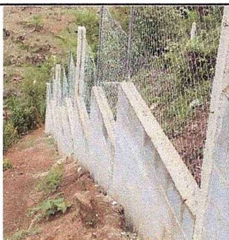
Foto 3: de esta forma quedo la parte norte del predio
